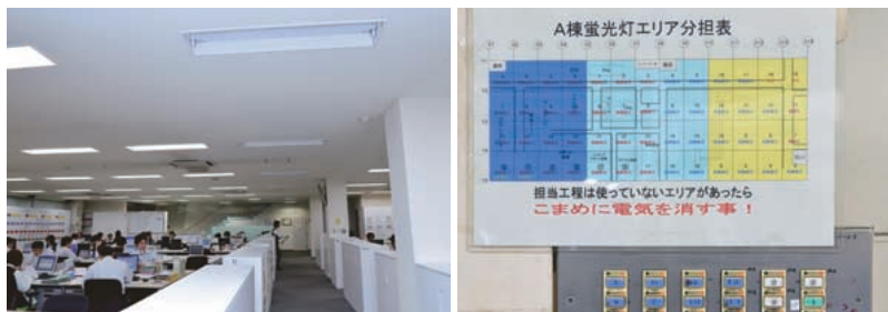
蛍光灯の間引き(写真左)や、蛍光灯の区画の細分化(写真右)により、オフィスの電力使用抑制を図る。
