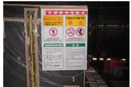
施工現場出入口
